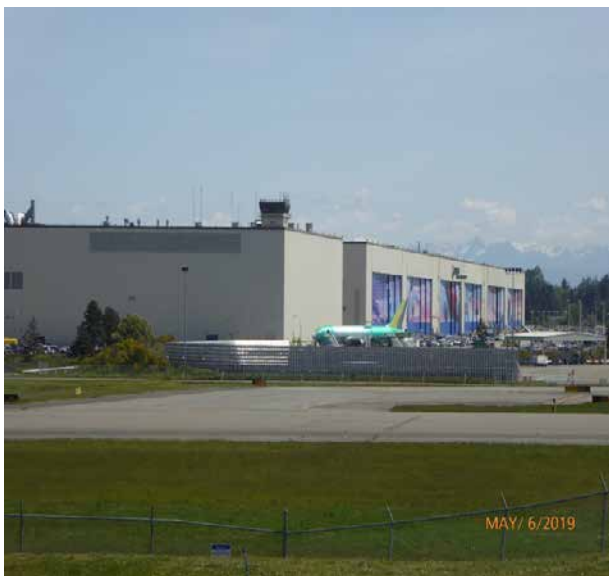
波音組裝廠一棟全世界最大的單一廠房，高達三四層樓佔地約有四萬平方米
