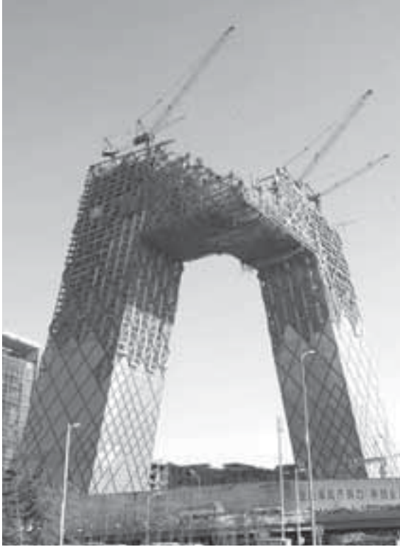
圖三 真玄！CCTV 兩個斜塔的懸臂正在合攏
