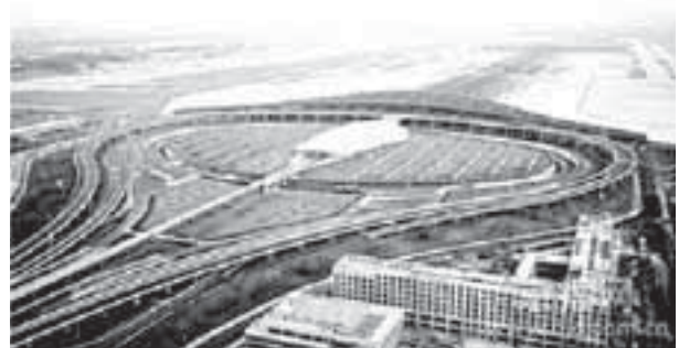
圖四 臥龍在地，北京新機場
